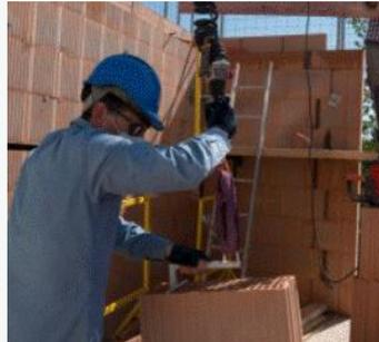
Le bras de manutention mécanisé permet de lever aisément des briques pesant jusqu'à 35 kg
